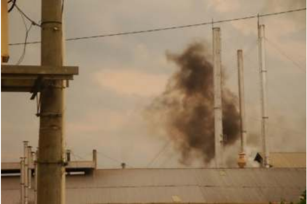
Gambar 45. Asap Pekat dari Cerobong Asap PT DSN yang Menimbulkan Bau Tidak Sedap
